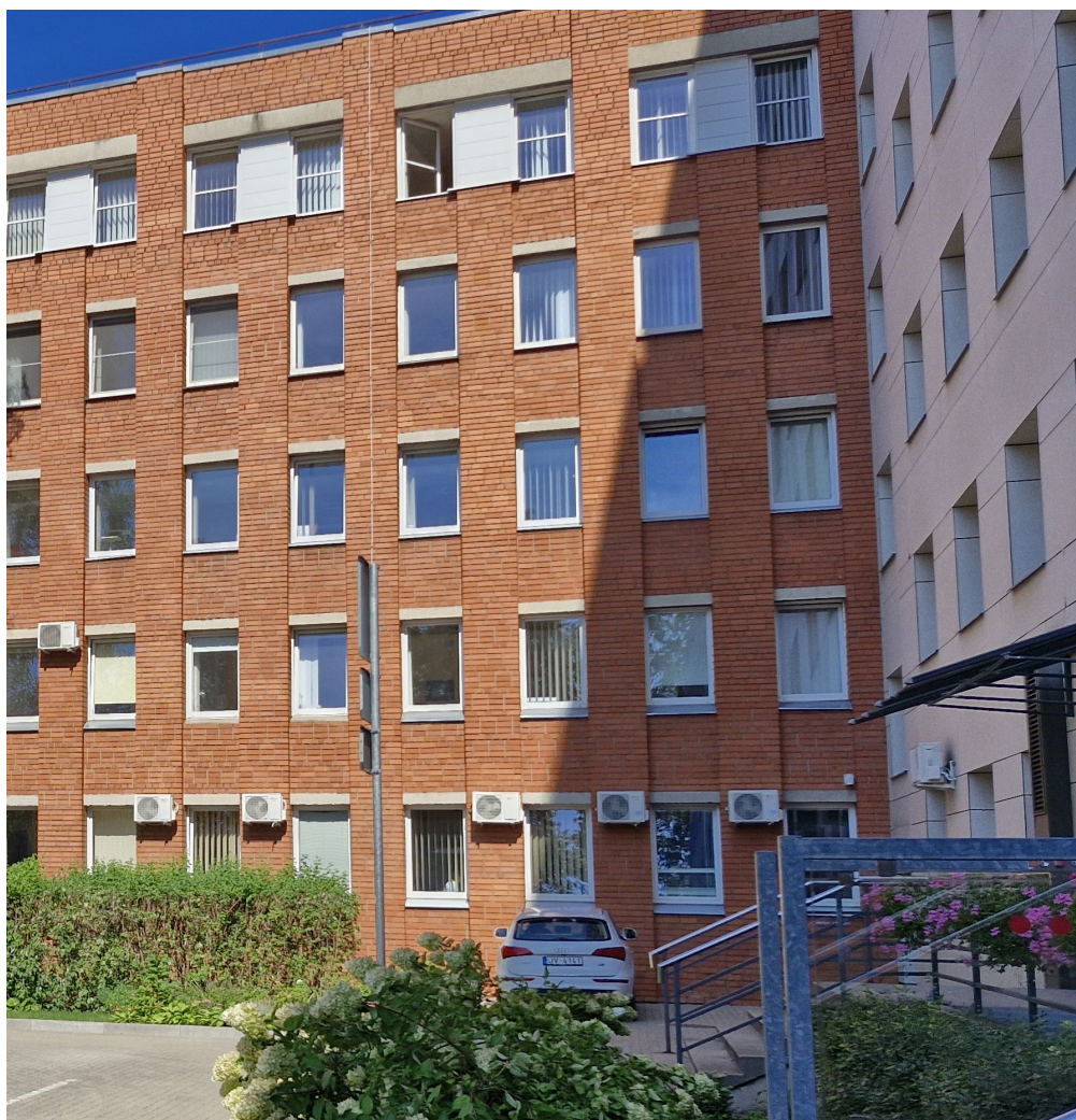
Dzemdību nama ēkas korpuss K-2
