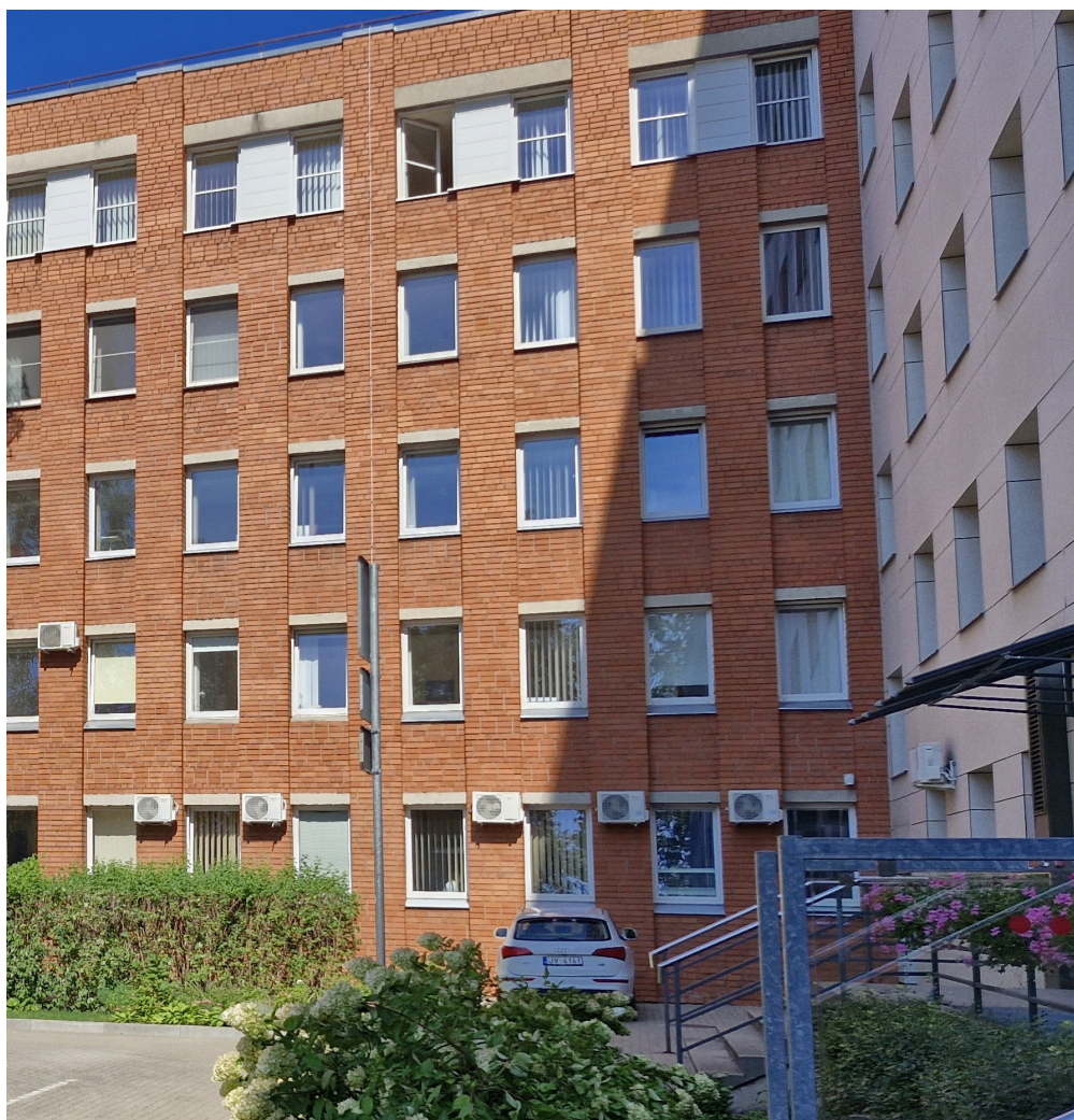
Dzemdību nama ēkas korpuss K-2
